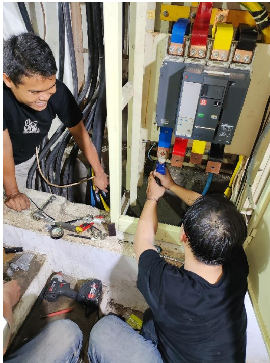
Gambar 2.14 Perbaikan Mesin Genset
